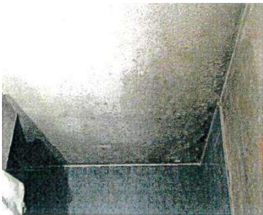
Exemples de moisissure sur le plafond de la salle de bain, ventilation bouchée et défectueuse (2019 /2020)
