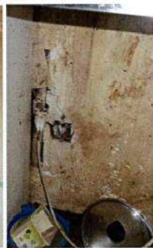
Exemples de moisissure sur le plafond de la salle de bain, ventilation bouchée et défectueuse (2019 /2020)
