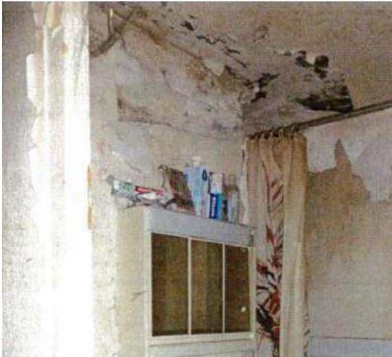
Exemples d'infiltrations d'eau et d'effondrement de plafond (2019 /2020)
