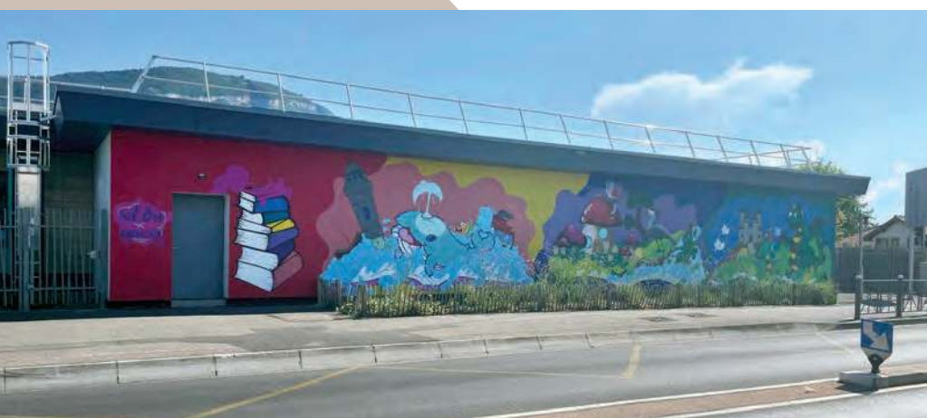
L'ÉCOLE DU SALÈVE APRÈS TRAVAUX 5
