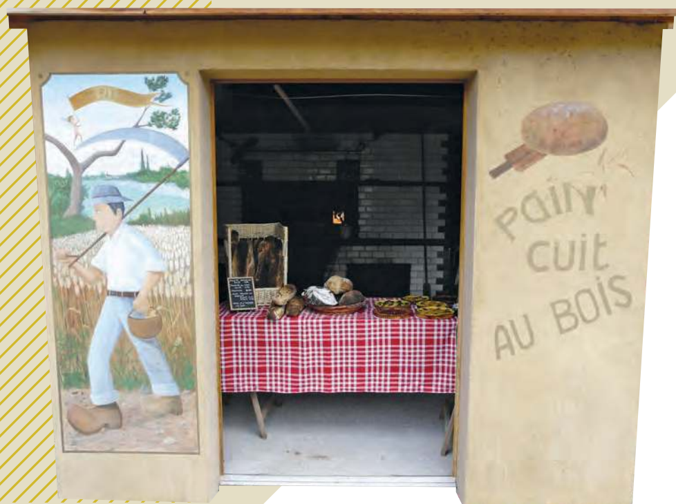
FOUR À BOIS DE LA RUE DU MÔLE
