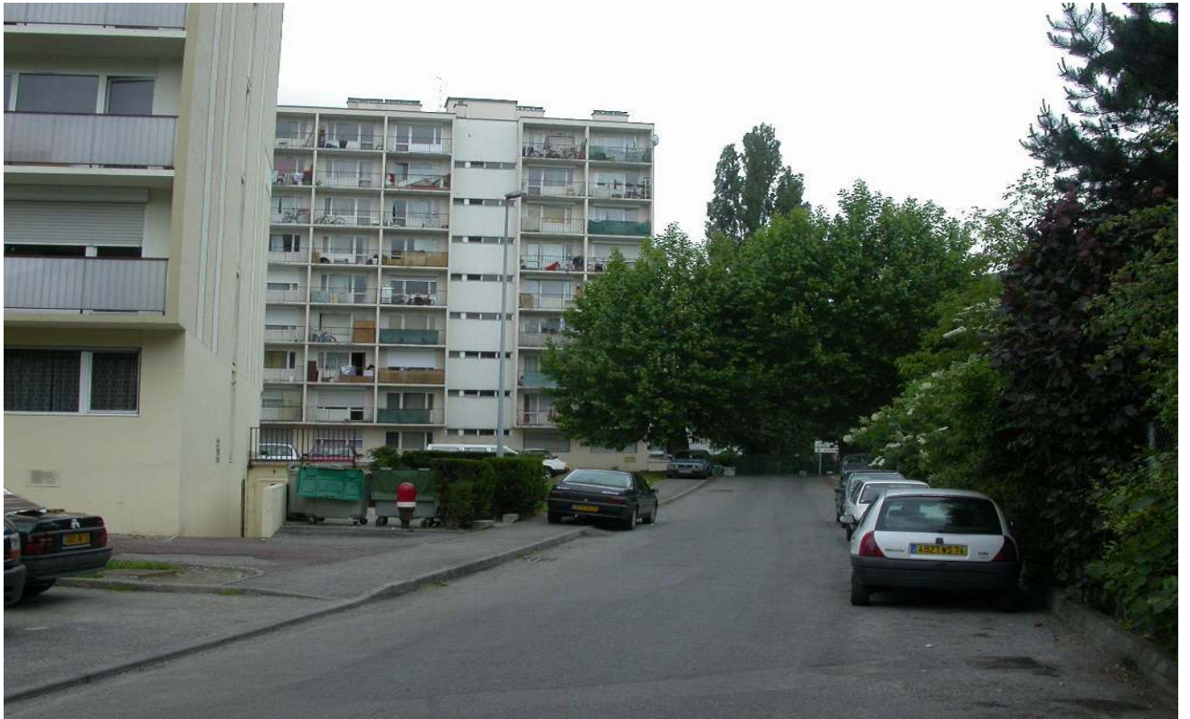
Quartier des Terreaux
