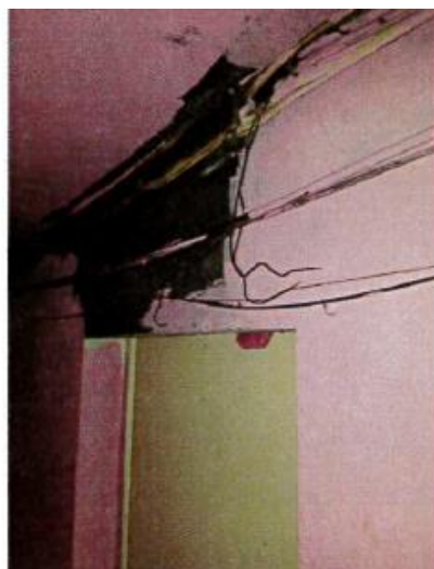
Exemples de dégradation d'enduit et des passages ouverts du réseau électrique (2019/2020)
