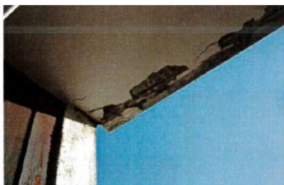
Exemples de possibles chutes de béton depuis la façade extérieure (bâtiment A, bloc B et C)
