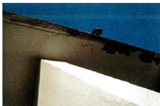
Exemples de possibles chutes de béton depuis la façade extérieure (bâtiment A, bloc B et C)
