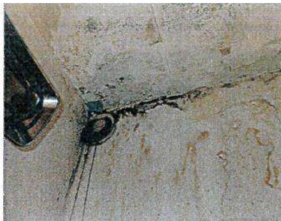
Exemples de moisissure sur le plafond de la salle de bain, ventilation bouchée et défectueuse (2019 /2020)
