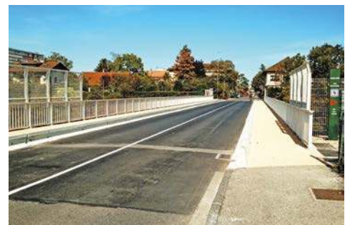
Travaux : MODERNISATION ET SÉCURITÉ
