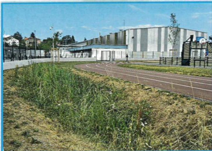
Désimperméabilisation de la cours d'école et noue paysagère au collège
