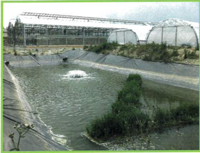
Récupération des eaux pluviales dans le bassin du centre horticole
