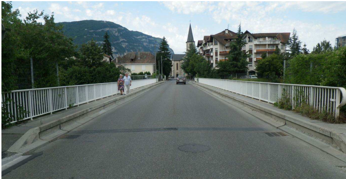
Vu de l'extrados de l'ouvrage
