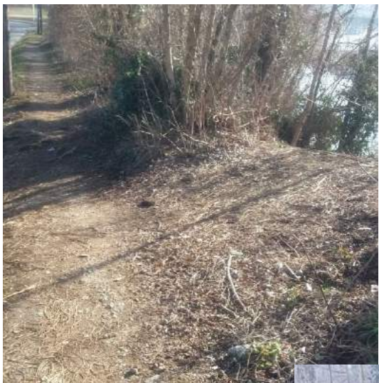
Tassement et végétations gênantes
